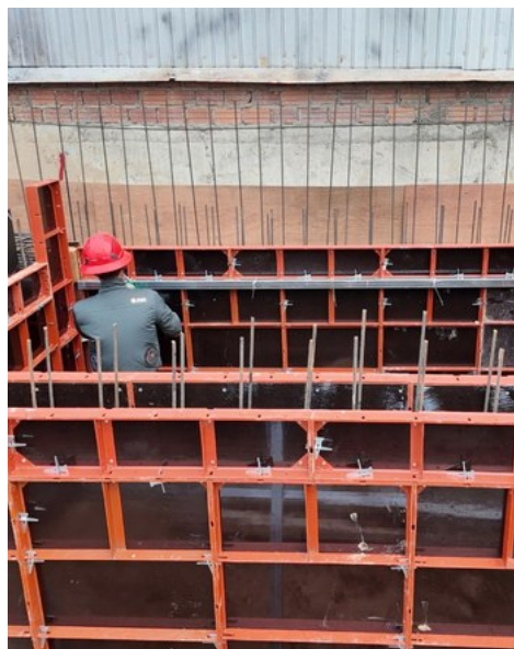
03 / LẮP DỰNG CỐT PHA THỰC TẾ
